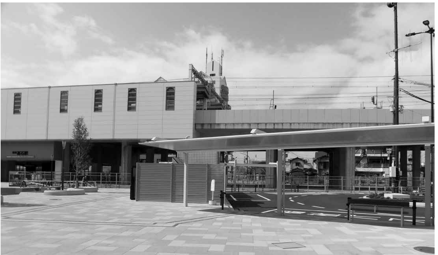
高石駅前広場（東側）整備工事が完了し、3月11日から供用開始されました。
