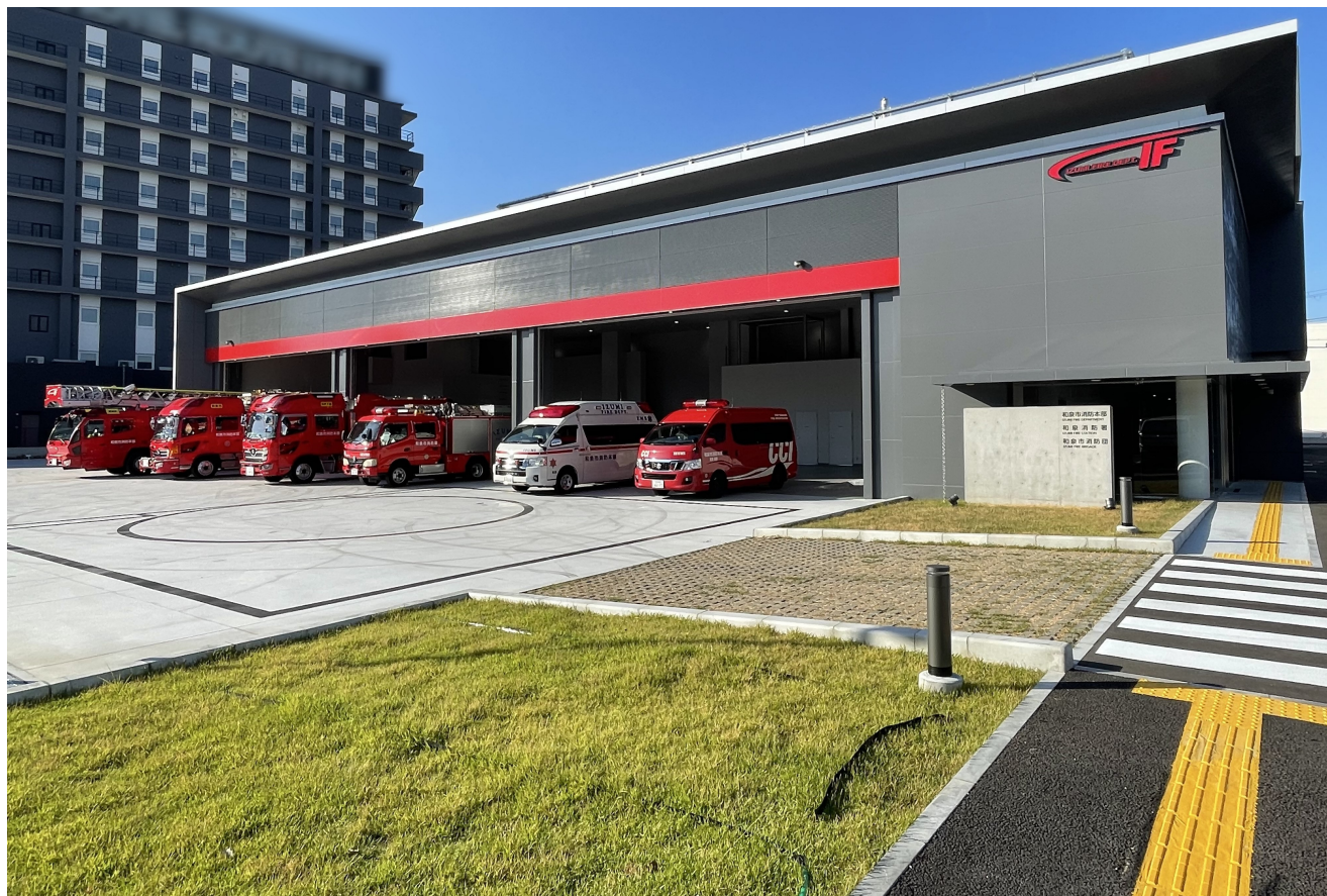
消防本部（令和6年12月1日開署・府中町4丁目）
